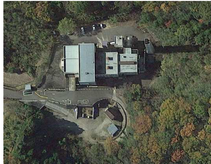
解体工事の対象
