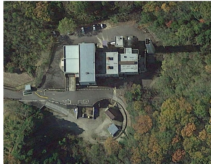
解体工事の対象
